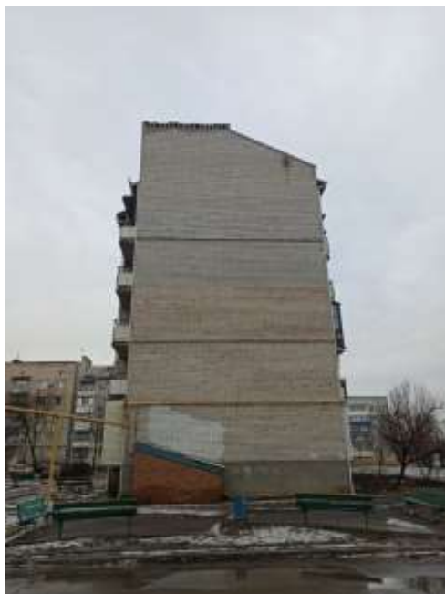
Рис 2. Фасад многоквартирного дома (торец)
